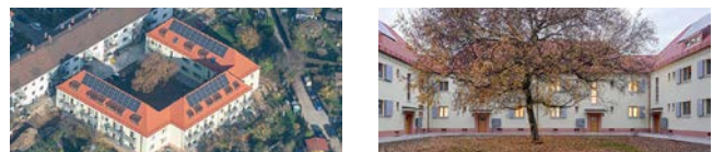
Abb. 63 und 64: Das Demonstrationsgebäude im Quartier Margaretenau. Im Bild rechts die Außeneinheit der Wärmepumpe.
