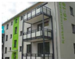
Abb. 49: Gebäude nach Sanierung
