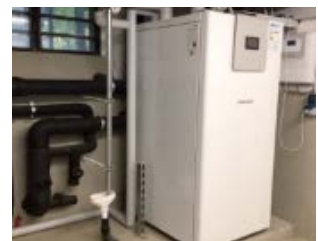
Abb. 51: Sole-Wasser-Wärmepumpe
