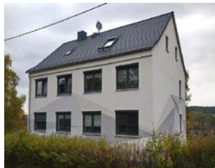
Abb. 40: Gebäude nach Sanierung
