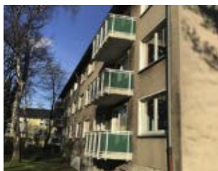
Abb. 48: Gebäude vor Sanierung
