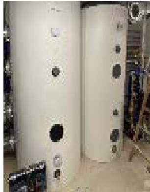
Abb. 45: Zentrale Trinkwasser-speicher
