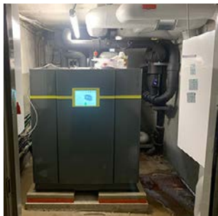
Abb. 57: Wärmepumpe
