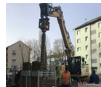
Abb. 54, 55, 56: Gebäude (li.) aus der Vogelperspektive, das angebaute Müllhaus mit Außenlufteinheit auf der Giebelseite (Mitte) und Montage der Erdwärmesonden (re.)
