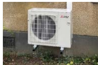
Abb. 43: Einzelnes Außengerät
