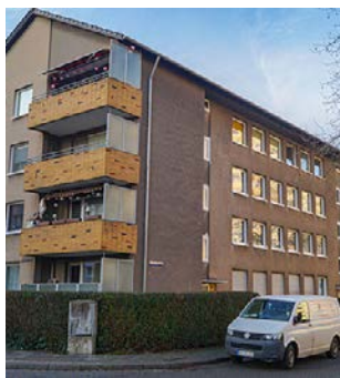
Abb. 65: Gebäude vor der Sanierung
